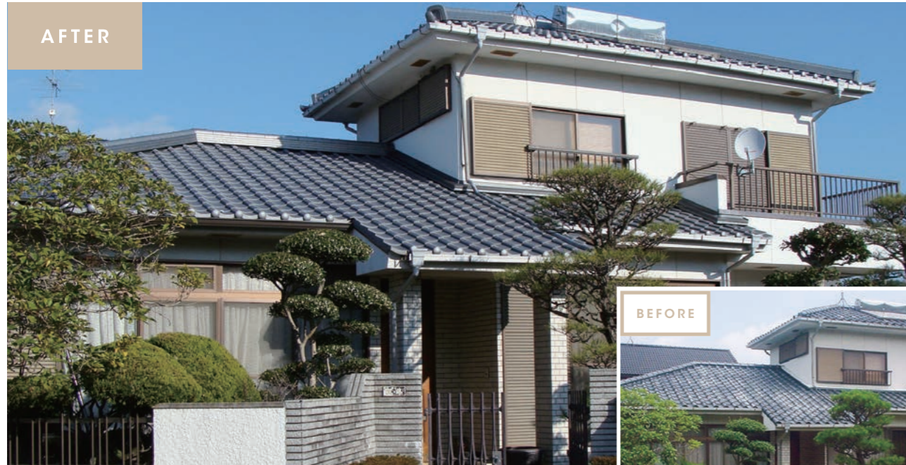
Before<釉薬S型瓦> ▶ After<いぶし和形瓦> 棟を積まない洋風S瓦から棟を積む和風屋根にすると家に重厚感を与えます。
