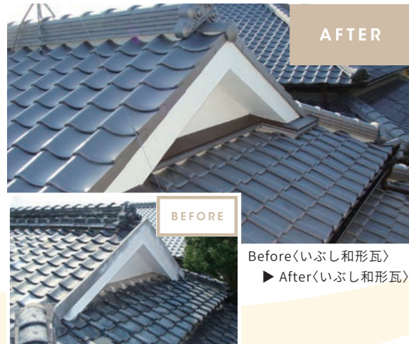
Before<釉薬S型瓦> ▶ After<いぶし和形瓦> 棟を積まない洋風S瓦から棟を積む和風屋根にすると家に重厚感を与えます。
