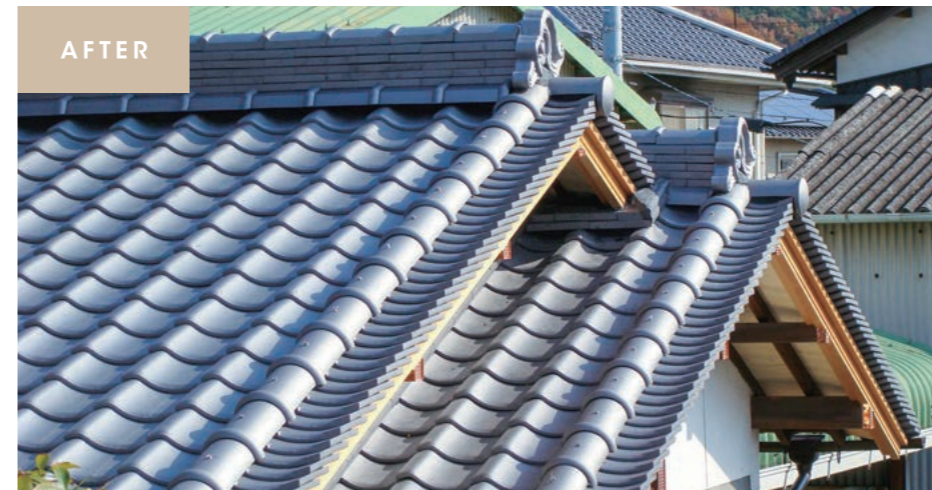
Before<釉薬和形瓦> ▶ After<いぶし和形瓦>
