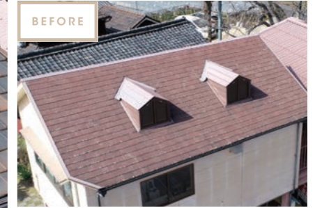
Before<カラーベスト瓦> ▶ After<窯変平板瓦>
